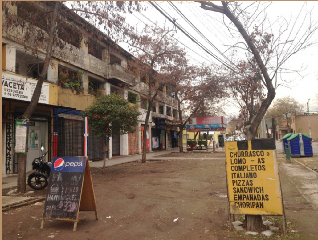
“Los colectivos” conservan en su fachada la estética original que mantiene la riqueza de la forma e imagen de la construcción de los años 30.
